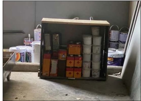
ภาพที่ 2.2-29 การจัดเก็บวัสดุที่ติดไฟง่าย
