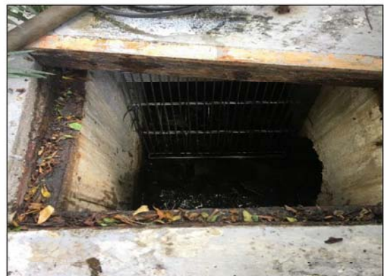
ภาพที่ 2.2-7 ตะแกรงดักเศษขยะที่บ่อพักน้ำสุดท้าย
